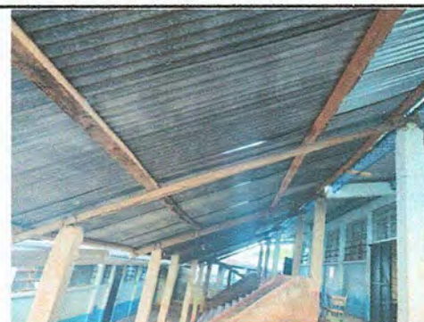
Foto 3: TRIBUNA ESCOLAR CAMBIO DE CUBIERTA DE LAMINA Y VIGAS DE MADERA A METAL.
