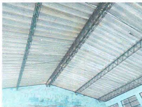
Foto 2: TERCERO "A" CAMBIO DE CUBIERTA DE LAMINA
